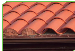
Figura 7. Tejas cerradas con greda (Universidad de California).
