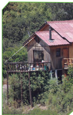
Figura 24. Terraza con acumulación de combustible.
