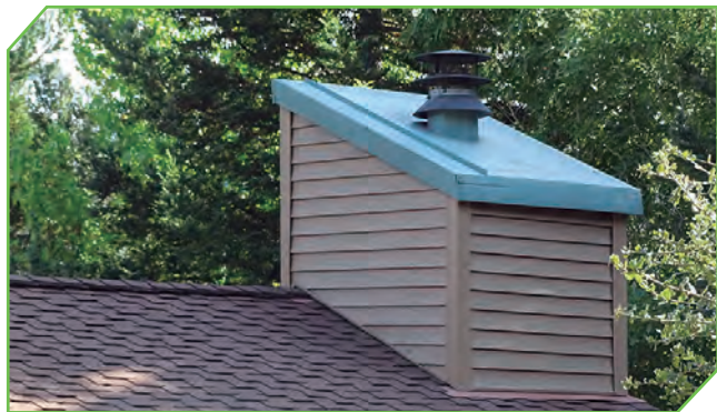
Figura 15. Chimenea despejada de vegetación.
